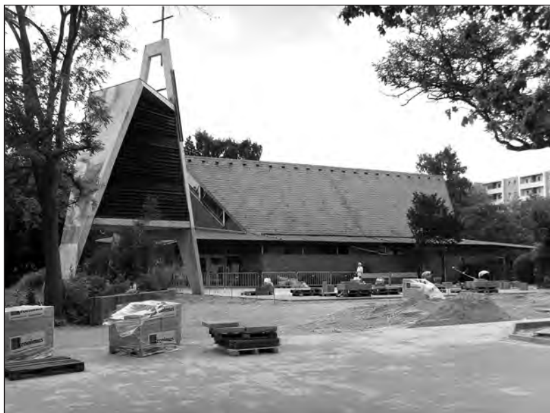
Henry-Dunant-Platz im Bau
